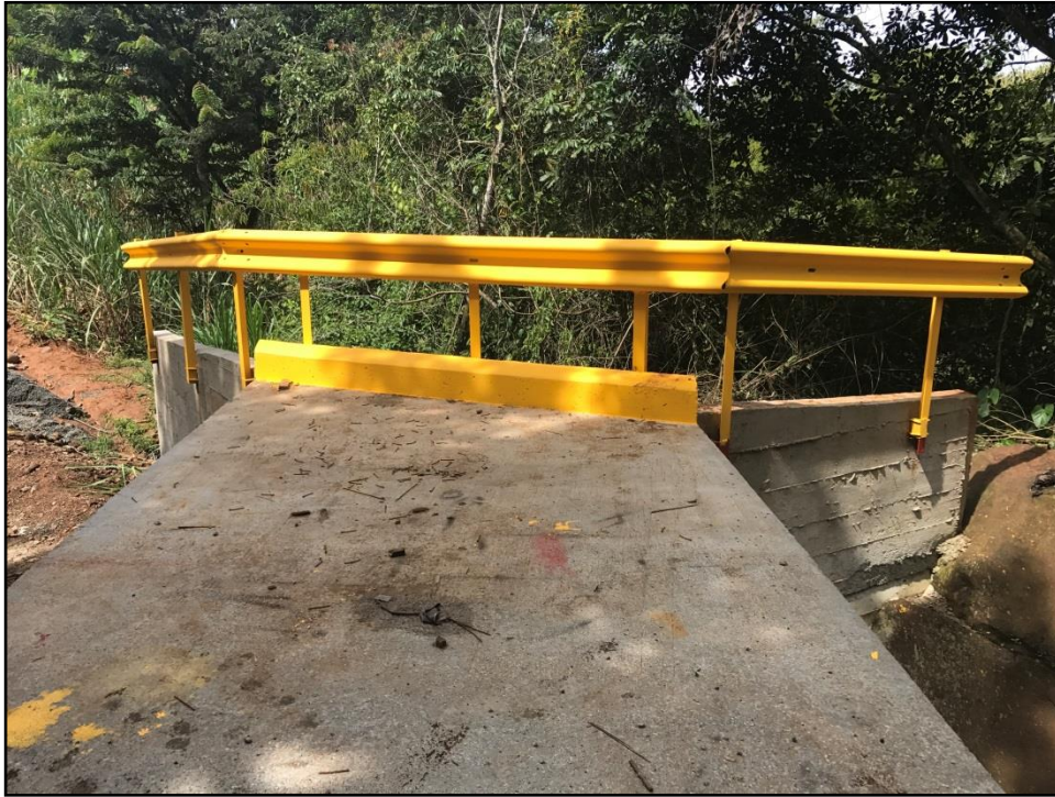
Alcantarilla de Cuadro Los Quirós, San Ramón Sur.
