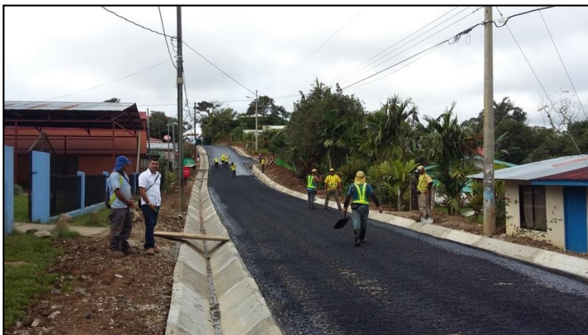
Pavimento La Luz del Mundo, San Cristóbal de Barú.
