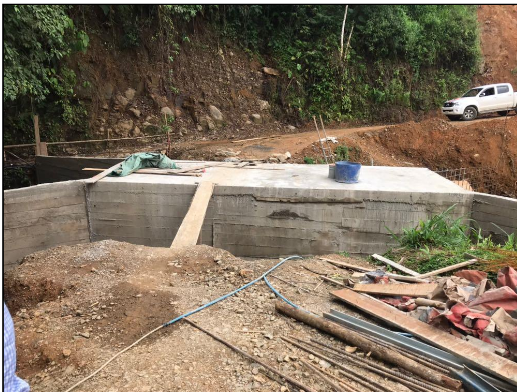
Construcción de alcantarilla de cuadro Valencia, Páramo.
