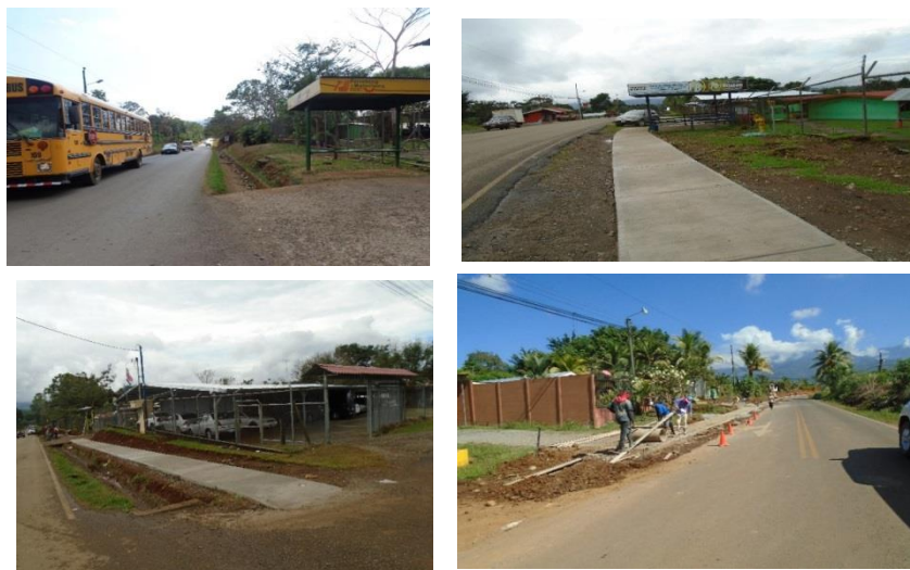
Arriba, vista de antes de la construcción de la acera. Demás vistas de la acera construida frente a la escuela y colegio de San Pedro
