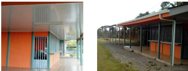
Vistas de cocina comunal finalizada de San Pedrito de Cajón Fuente: Subproceso de Proyectos Comunales
