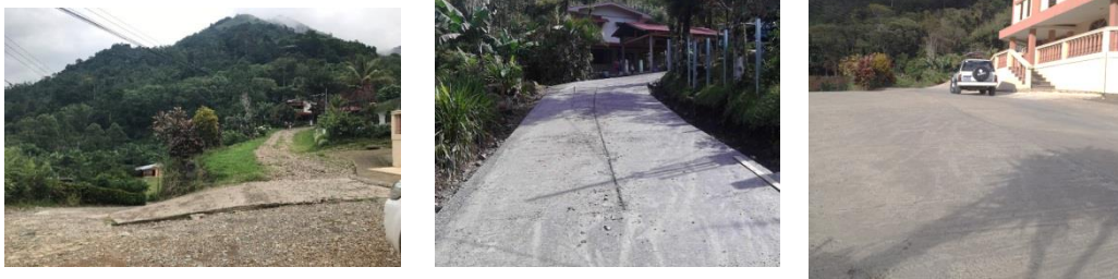
Vista interna del antes y después de la construcción del cementado
