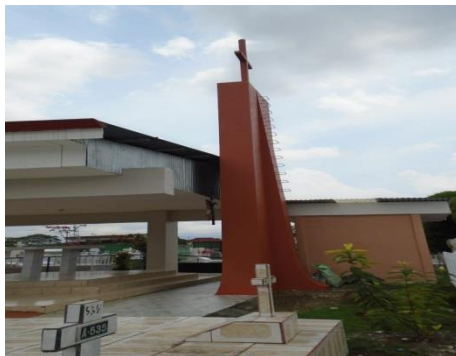
Foto #8. Pintado de torre.
