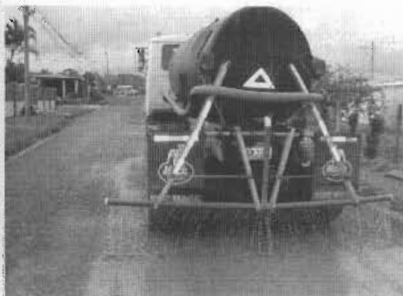
Compactación y Riego con tanque de agua
