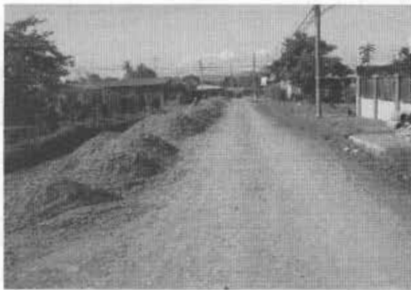
Colocación de la Base Granular
