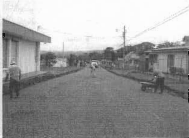
Colocación del Tratamiento Superficial Bituminoso
