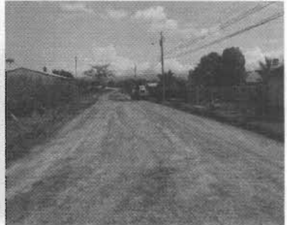
Conformación, ampliación y compactación de la Sub-Base
