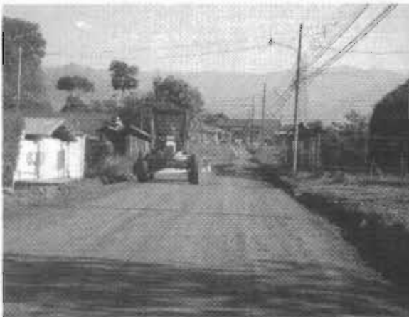
Conformación, ampliación y compactación de la Sub-Base
