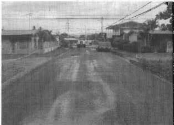
Compactación y Riego con tanque de agua
