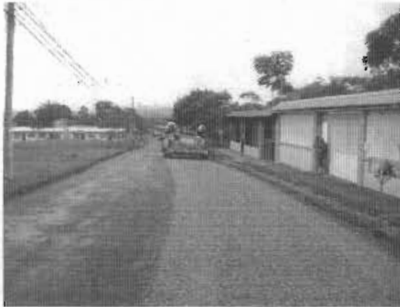
Colocación del Tratamiento Superficial Bituminoso
