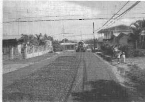
Colocación de la Base Granular
