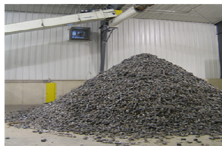
Acopio de CDR
