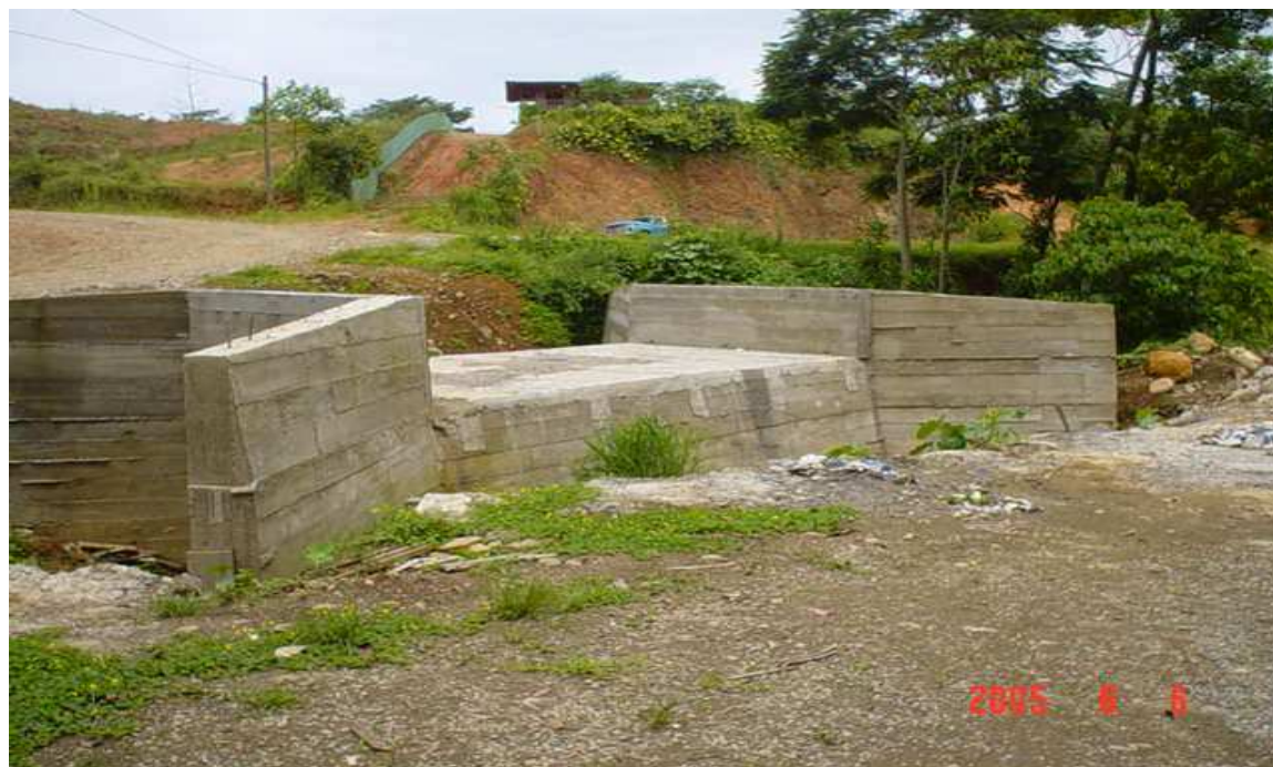
PUENTE FINCA MUNICIPAL
