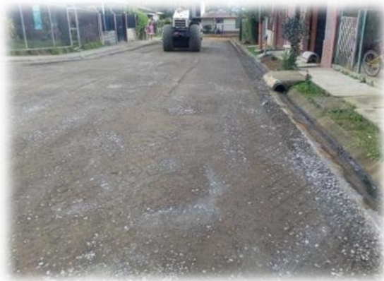
Durante la realización de obras
