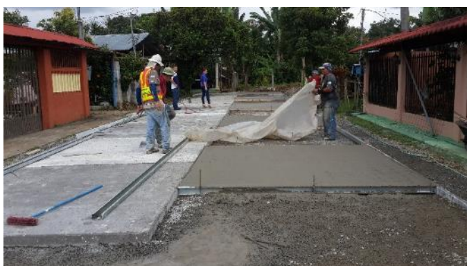
Cementado Calle Varela
