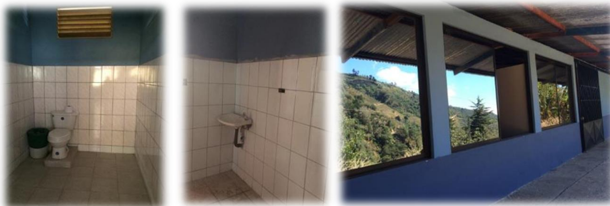
reparación de batería sanitaria.
