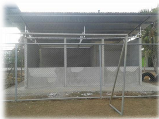
Estado actual de la obra
