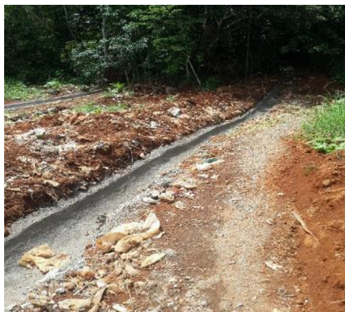
Construcción de cunetas en Proyecto de cierre Técnico de Vertedero Municipal
