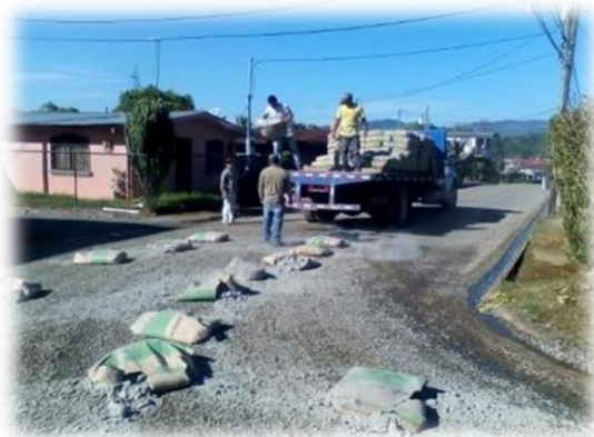
Estado del camino previo a realizar obras
