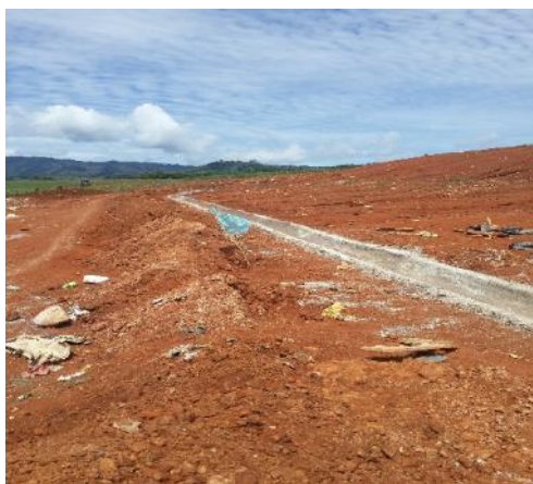
Construcción de cunetas en Proyecto de cierre Técnico de Vertedero Municipal
