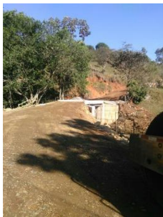
Puente Calle Porras
