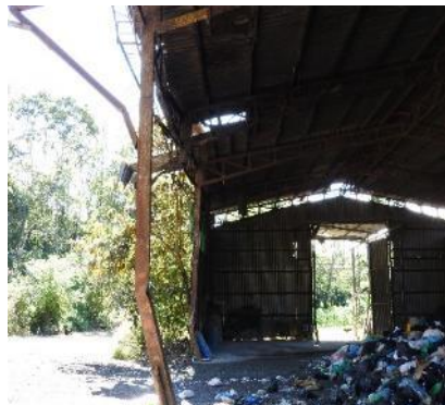
Inspección al terminar la sesión de trabajo de Análisis de Riesgos en el Centro de Transferencia.
